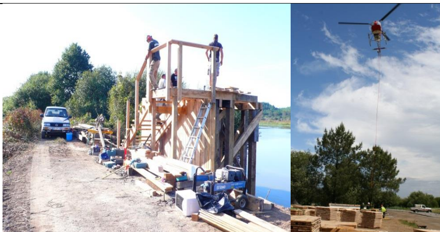
Observatoire surélevé N°3 .... Hélicitreuillage des matériaux sur le site
