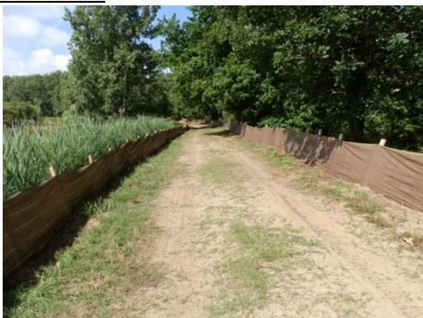
Clôture protection faune
