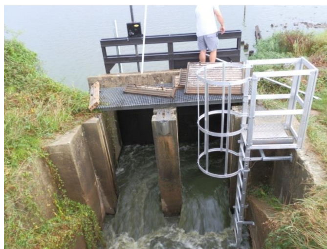
Réalisation entreprise DL Aquitaine (14 580,00€ TTC)
