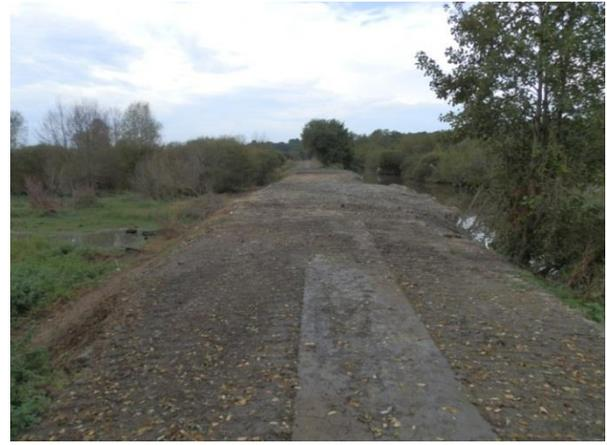
*17 juin 2013 renforcement et surélévation digue Est - Octobre 2013 : la digue Ouest après colmatage de la brèche, réparation et compactage*
