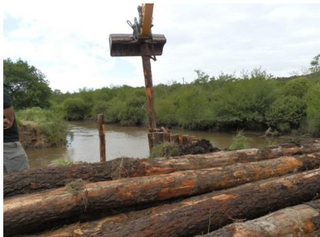
*23 mai 2013 : premières réparation brèche Canal Ouest avec création d'une fascine par mise en place de pieux bois à l'aide d'une pelle mécanique et apport de terre pour reconstruire la digue emportée par la surverse.*
