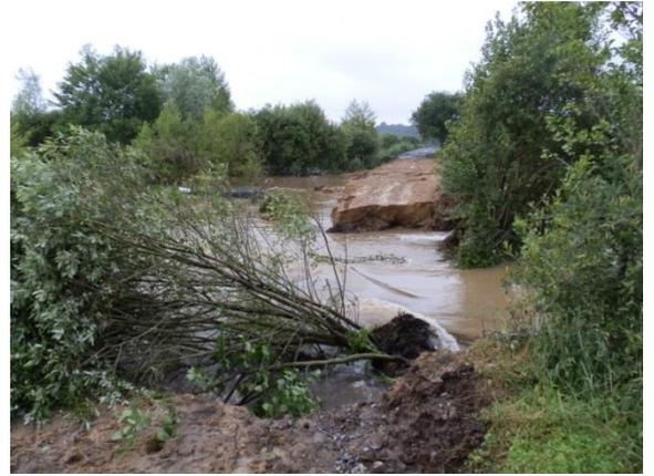
*10 juin 2013 : nouvelle rupture de digue Canal Ouest en amont de la brèche réparée*
