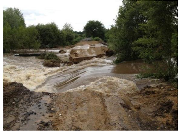
*Nouvel épisode pluviométrique et nouvelle surverse sur le pan de digue réparé sur la digue Ouest - Rupture des travaux de colmatage le 9 juin 2013 (108 mm)*
