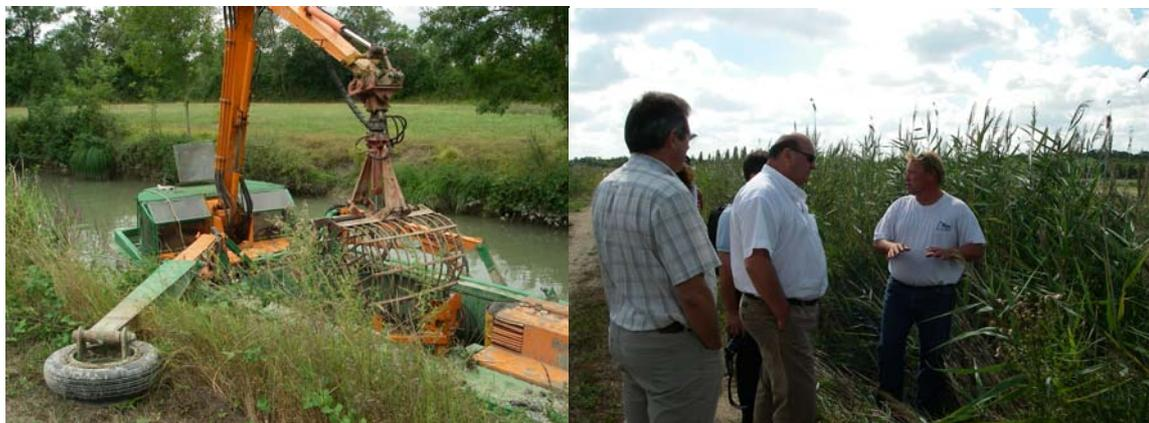
Ces travaux ont débutés à la fin du mois de novembre 2006 et sont réalisés par la combinaison de deux techniques : une pelle mécanique, équipée d'une griffe, procède à l'arrachage des herbiers de Jussie sur la plus grande largeur possible du canal (2/3 environ selon les secteurs) à partir de la digue ; le reste du canal est traité au moyen d'une mini-pelle sur barge flottante.
