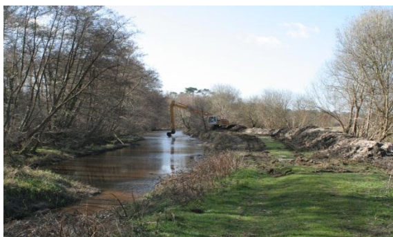
Février 2010. Travaux sur le canal Est.
