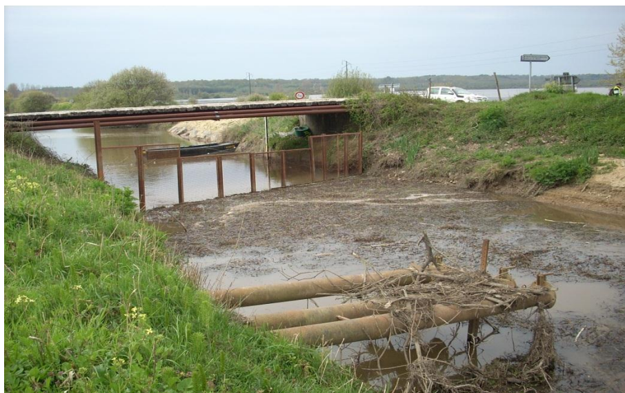
Avril 2010. Le barrage sur le canal Est au niveau du pont de Burret.
