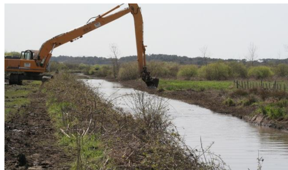
Avril 2010. Travaux sur le canal Ouest
