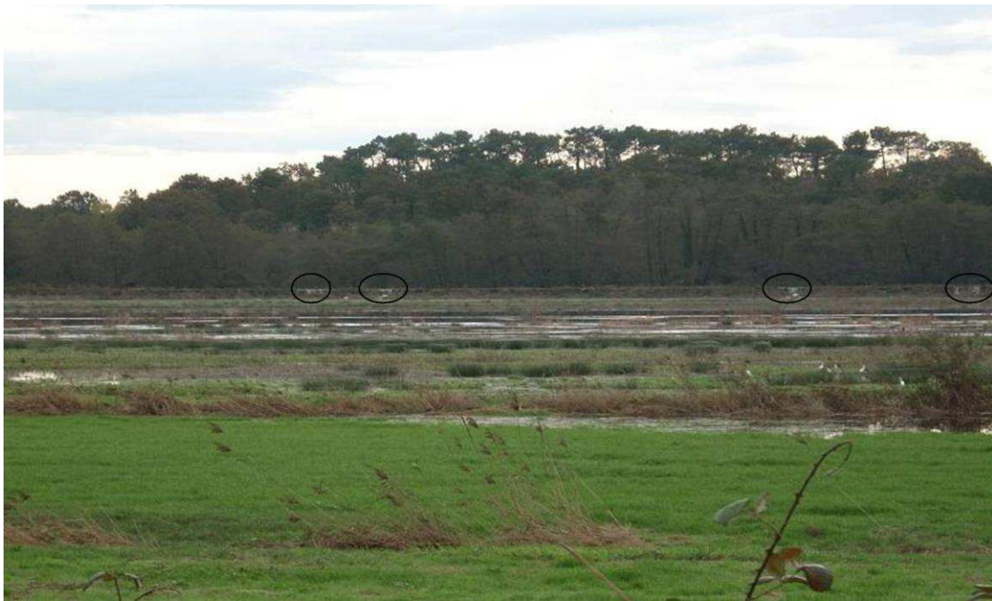
Visualisation des points de submersion de la digue Est (06/11/2009)
