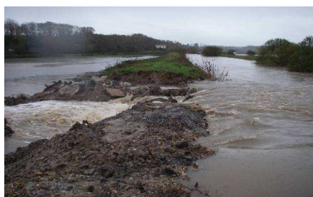
Brèche à proximité du siphon (2 décembre 2008)
