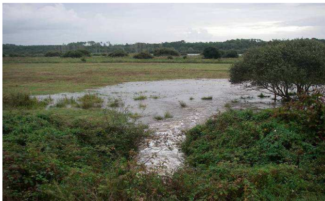
Ouverture de la vanne de Congrès pour délester le canal Ouest
