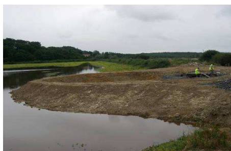
Merlon de protection au niveau du siphon (2009)
