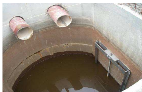
Vue du siphon (2009)
