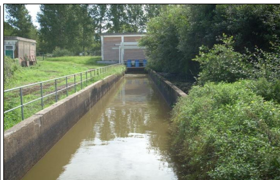
Canal d'amenée après travaux
